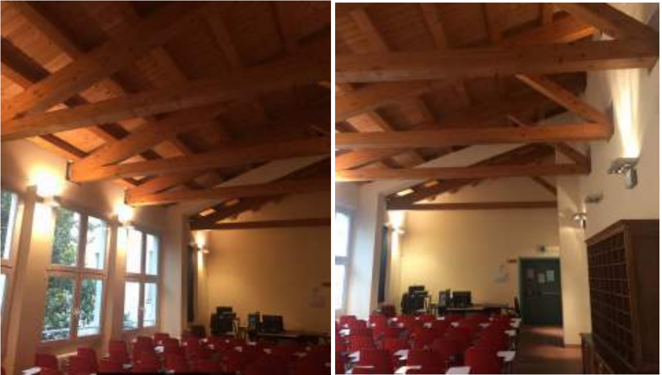
Copertura con capriate in legno che poggiano su cordolo in c.a. del Corpo C
